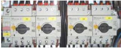
Abb. 4: Motorschutzschalter
